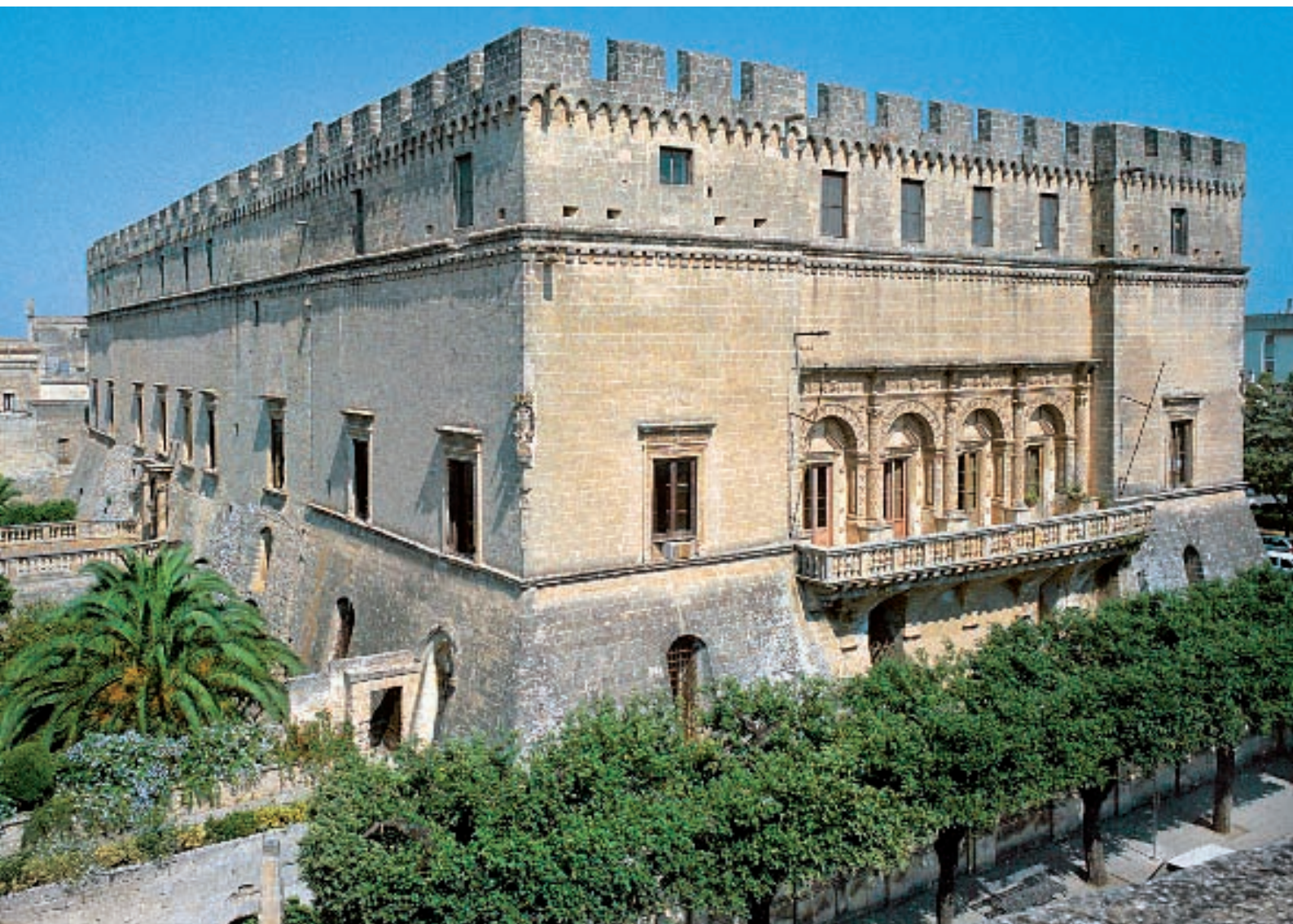
Francavilla Fontana (Br), Castello Imperiali, in alto: ingresso Meridionale - Foto APT
